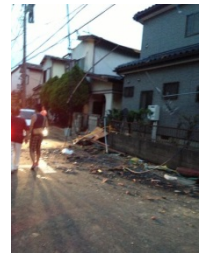
大里地区の被災住宅
