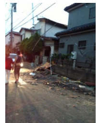
大里地区の被災住宅
