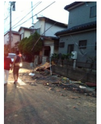
大里地区の被災住宅
